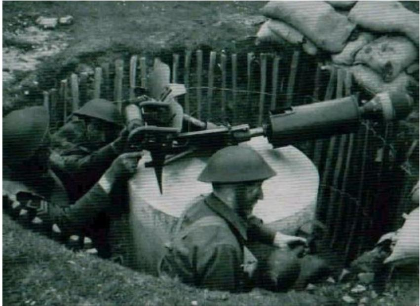
Obligado por la pérdida de material durante la evacuación de Dunkerke, el ejército británico debió improvisar armamento para hacer frente a la temida invasión. Un ejemplo es el emplazamiento para los morteros Spigot. Se trataba de una fortificación de concreto con el cilindro reforzado en acero para la colocación del mortero. Como defensa estática se preveía que fueran efectivas. En la foto vemos a la dotación de un mortero Spigot montado en su base.
