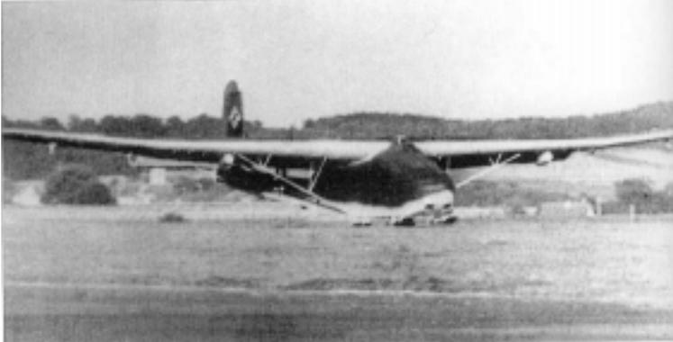
El Messermicht Me-321, planeador diseñado para la operación Seelöwe y evidentemente, no usado en la misma. En la foto se observan los patines de un Me-321 posado en tierra. Era remolcado principalmente por dos He 111 unidos con un ala en común y un quinto motor central.
