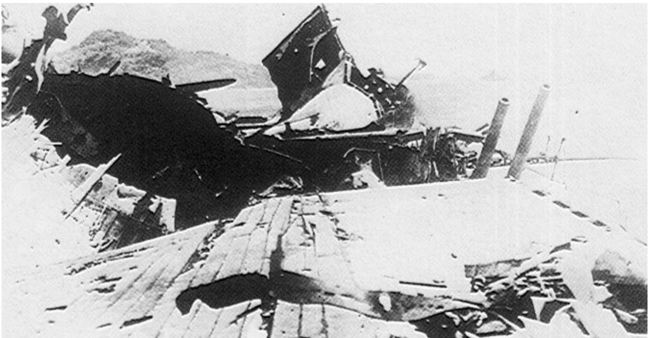
Mismos daños que la foto anterior vistos desde la cubierta de vuelo, producidos por la segunda y tercera bombas.
