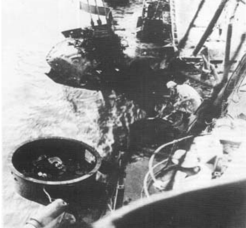
Daños de la segunda bomba que alcanzó al Shokaku el 8 de Mayo de 1942.
